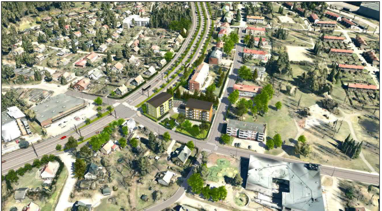
kuva 1: Havainnekuva, kuvakulma yläviistosta lounaan suunnalta katsottuna. © Arkkitehtitoimisto Helamaa & Heiskanen Oy, 2022; Tampereen kaupunki, 2022
